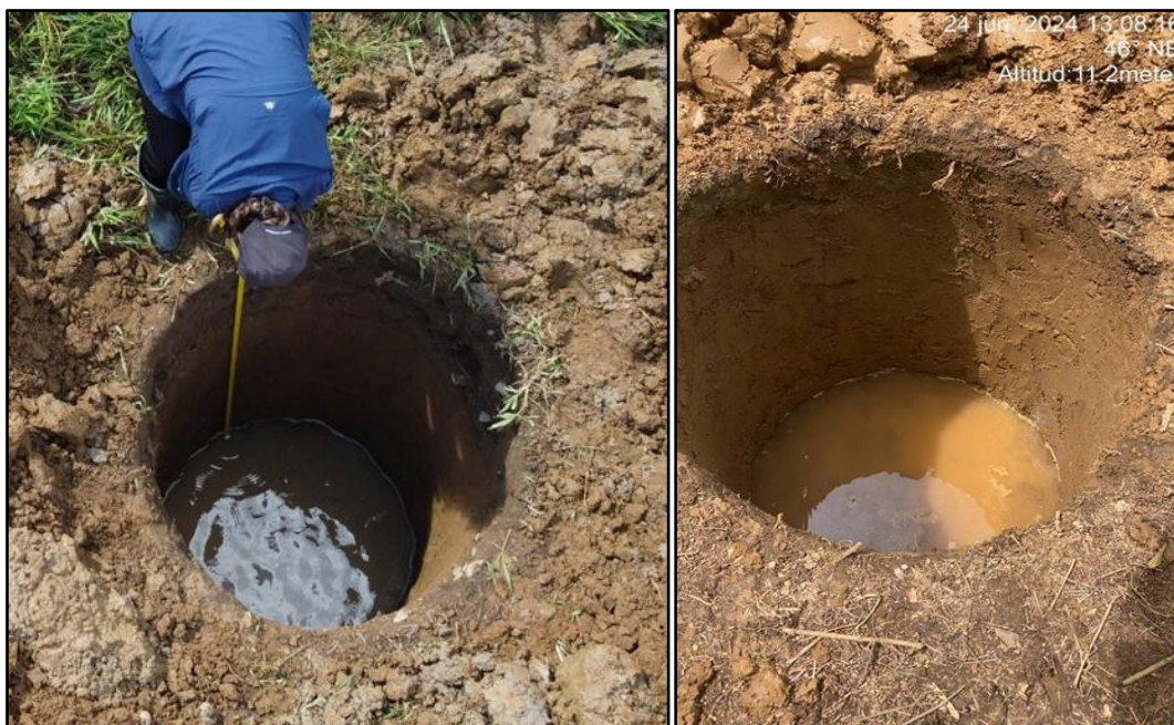
Figura 66. Vista de pozos de rueba con agua subterránea aflorando. Evaluación Arqueológica Proyecto Aeropuerto Internacional del Sur
